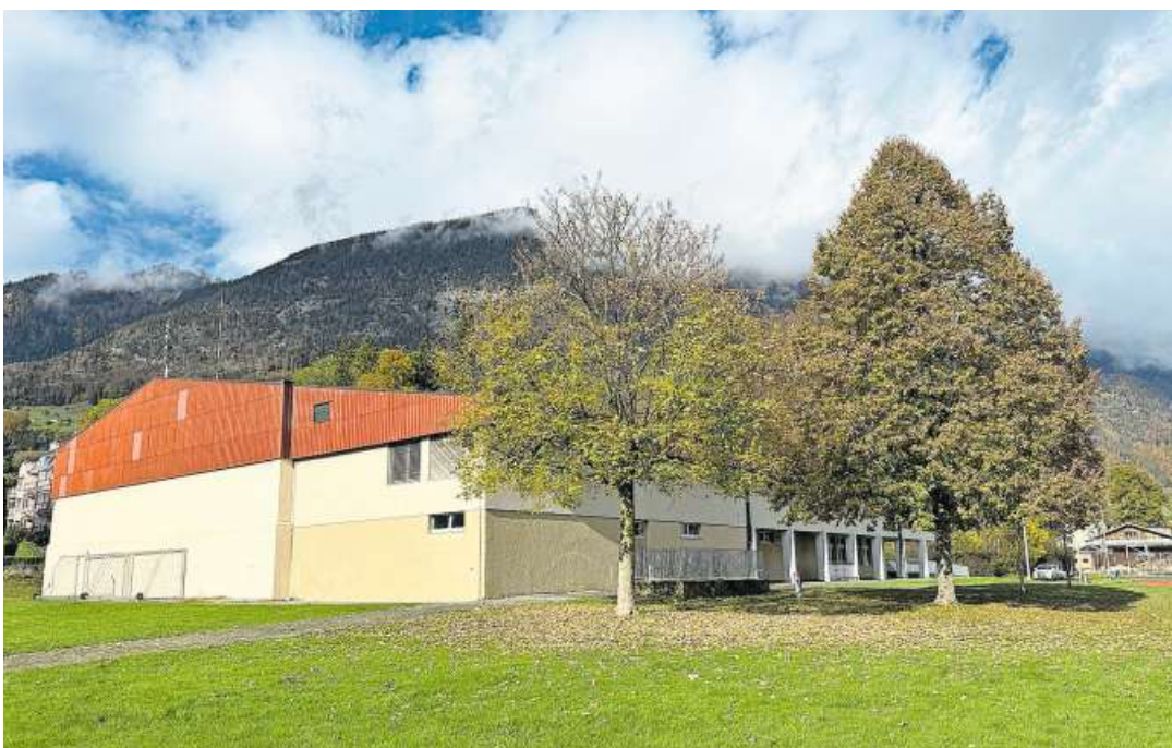
Das Bild zeigt die Sporthalle in Alpnach aus dem Jahre 1981, die im Zuge der neuesten Schulraumplanung saniert werden soll.
